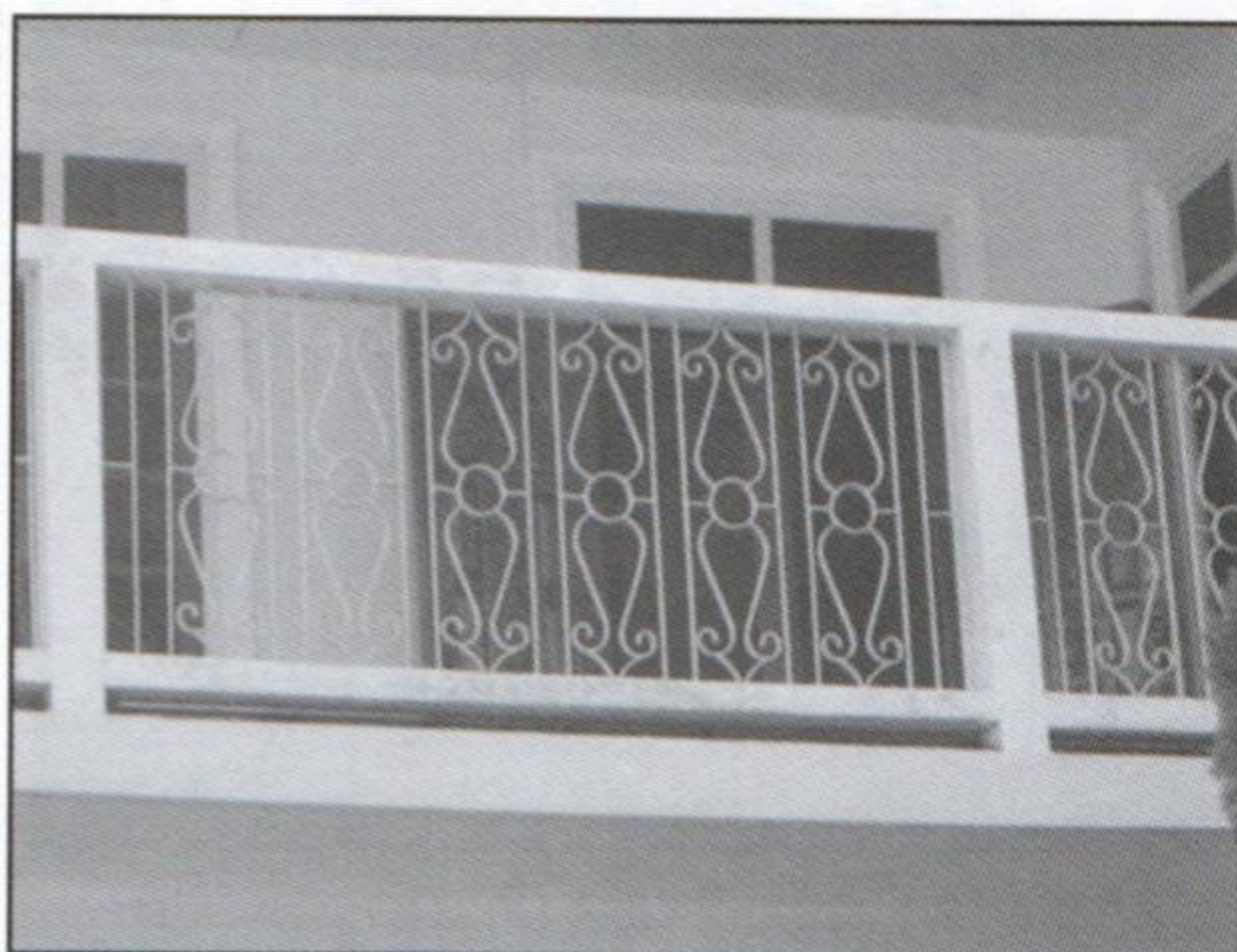
ພະນັກເປັນໂຄງເຫຼັກສຳເລັດຮູບ
