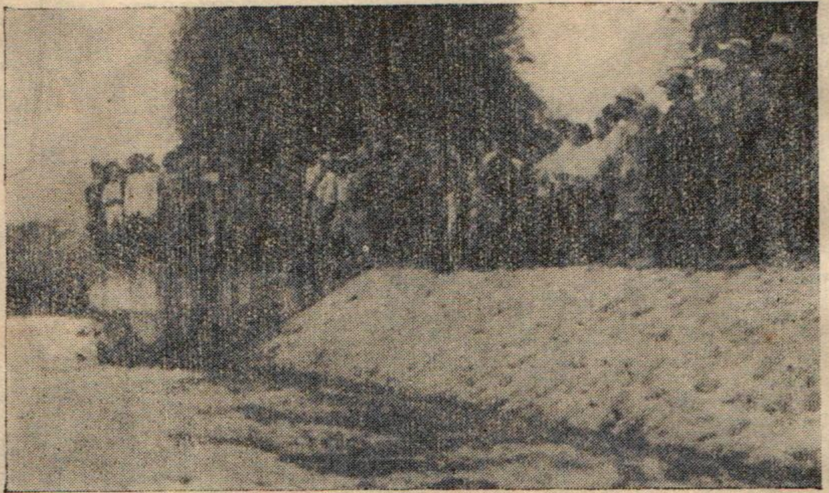
Un barrage construit par la population de Xieng Khouang avec l'aide de l'administration provinciale.
